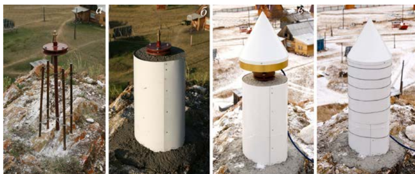
Рис. 3. Этапы установки антенны ГНСС на скальном основании в пункте наблюдения UZUR (а–д)
