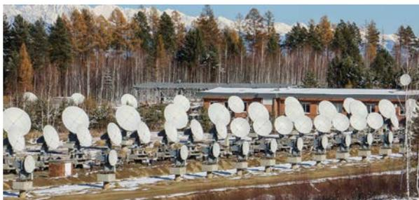
*Рис. 1.1.1.* Общий вид радиогелиографа. Антенны с разными диаметрами рефлекторов относятся к разным решеткам, работающим в диапазонах 3–6, 6–12, 12–24 ГГц
