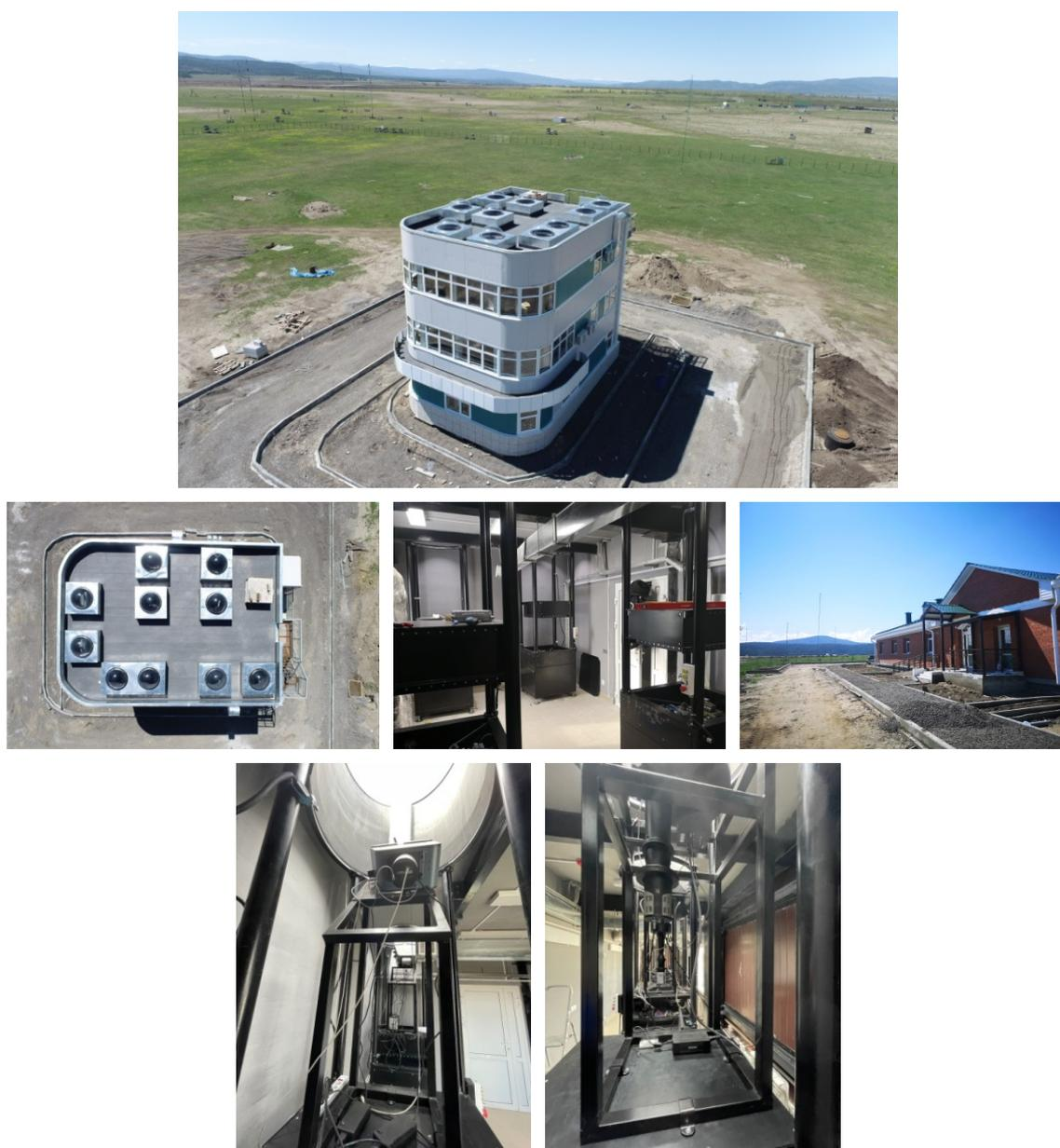
Рис. 1.2.1. Здание нового технического помещения (виды сбоку и сверху) для оптических инструментов и сами инструменты, размещенные в здании
