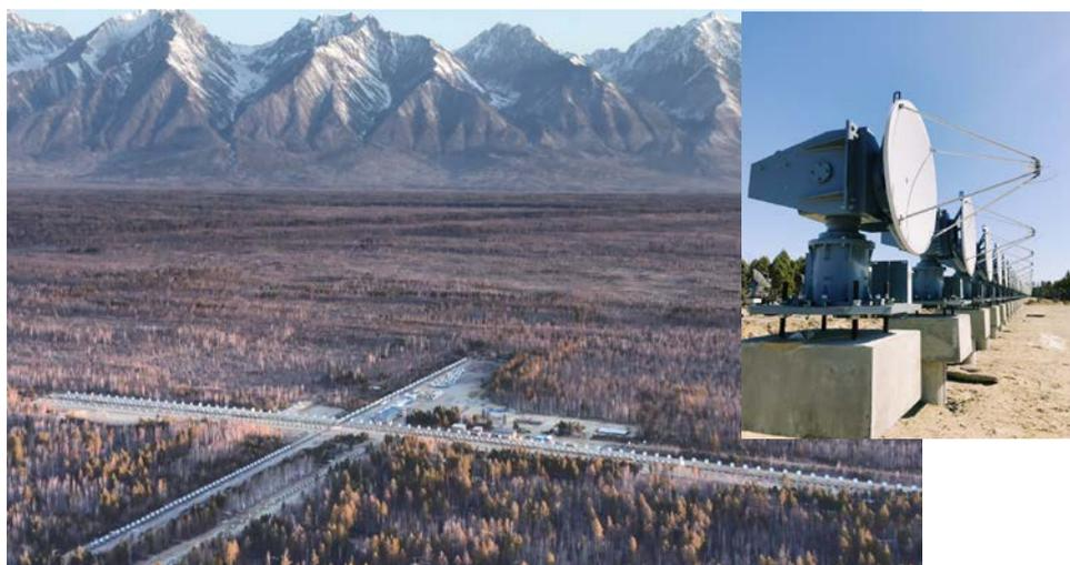
Рис. 3.3.1. Общий вид РАО с тремя Т-образными антенными решетками ССРТ и 1-метровый элемент антенной решетки 12–24 ГГц
