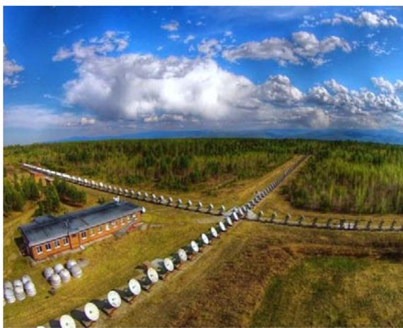
Рис. 3.3.1. Общий вид РАО. Крестообразная антенная решетка ССРТ и СРГ. Рядом со зданием расположены спектрополяриметры
