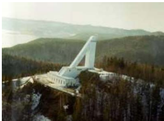
Рис. 3.9.3.1. Большой солнечный вакуумный телескоп
