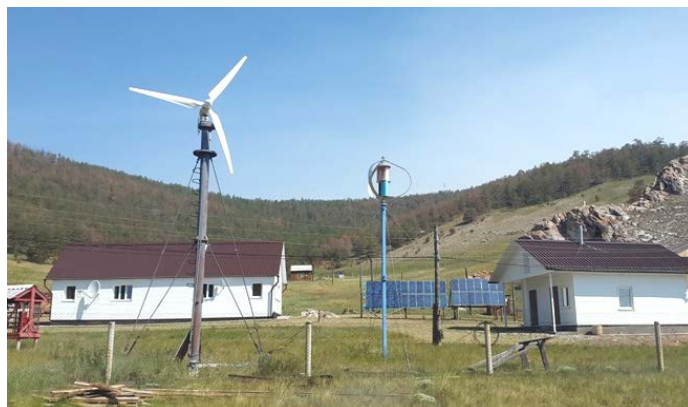
Рис. 3.6.2.2. Основные здания и сооружения Байкальской магнитно-теллурической обсерватории (на переднем плане и в глубине — компоненты солнечно-ветровой электростанции)
