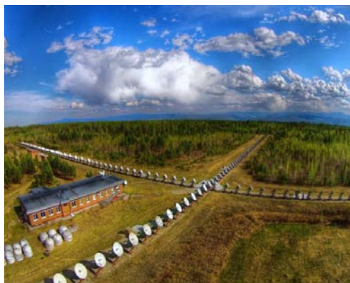
Рис. 3.3.2. Крестообразная антенная решетка ССРТ и СРГ. Рядом со зданием расположены спектрополяриметры
