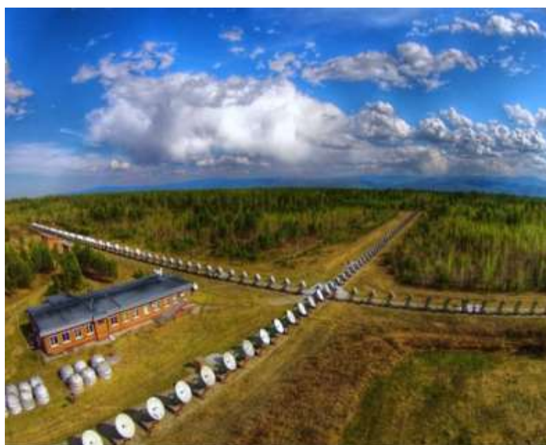
Рис. 162. Крестообразная антенная решетка ССРТ и СРГ. Рядом со зданием расположены спектрополяриметры
