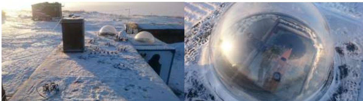
Рис. 170. Новый оптический купол (справа) и оптические купола и темостабилизированный контейнер для оптической аппаратуры (слева)
